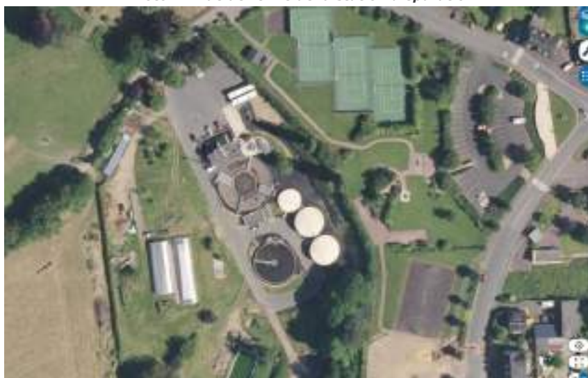
Photo 1 : Vue aérienne de la station d'épuration
