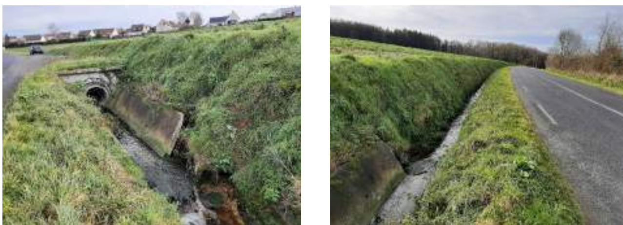
Figure 45 - Exutoire du réseau dans le fossé le long de la rue de Vire
