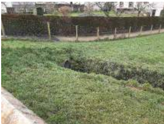
Figure 40 - Exutoire du réseau au niveau de la rue Pierre Curie
