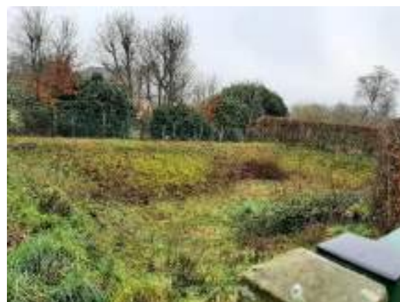
Figure 38 - Ouvrage d'infiltration sur la partie sud du lotissement
